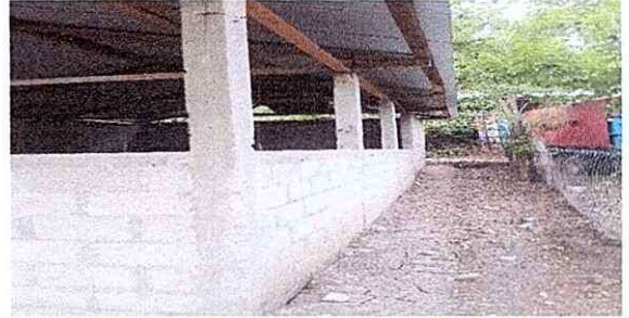
Foto 2: pintura de exteriores de las aulas
