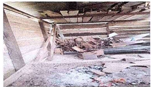
Foto 4: Cambio de costanera de madera a metal
