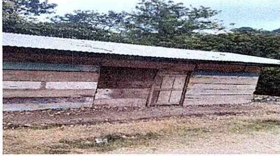
Foto1: ampliación de cocina
